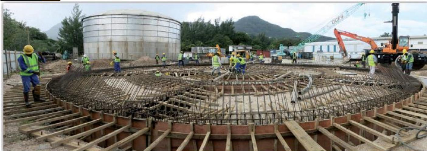
> Em uma fábrica de processamento de alimentos nas Seychelles, uma nova estação de tratamento de água foi construída. A prestação de serviço da Rincenc Recherche Expertise se relacionou à construção de uma estrutura de sustentação dos tanques de metal.
