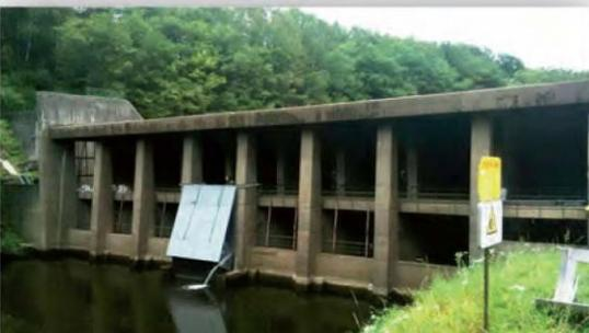
Na barragem sobre o Maulde, em Bujaleuf (87), tratava-se de diagnosticar o contato entre a blindagem e as estruturas de engenharia civil.
