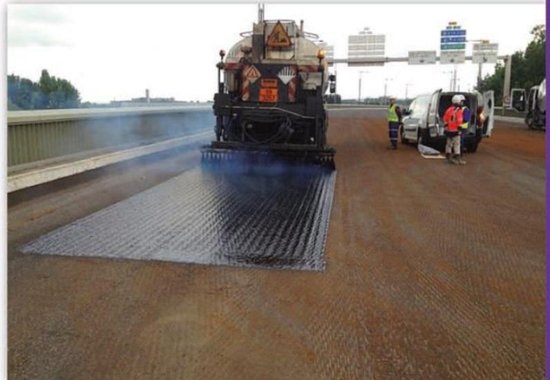
Quando a temperatura da membrana atinge  $40^\circ\text{C}$ , ela recebe sobre toda a sua superfície, a sua proteção em *ardoisine*, à razão de  $2.5$  a  $3 \text{ kg/m}^2$ .
